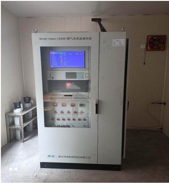
图 3.2.18-15 固废焚烧炉废气在线系统
