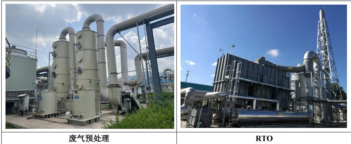
**图 4.1-4 废气处理设施现场照片**
