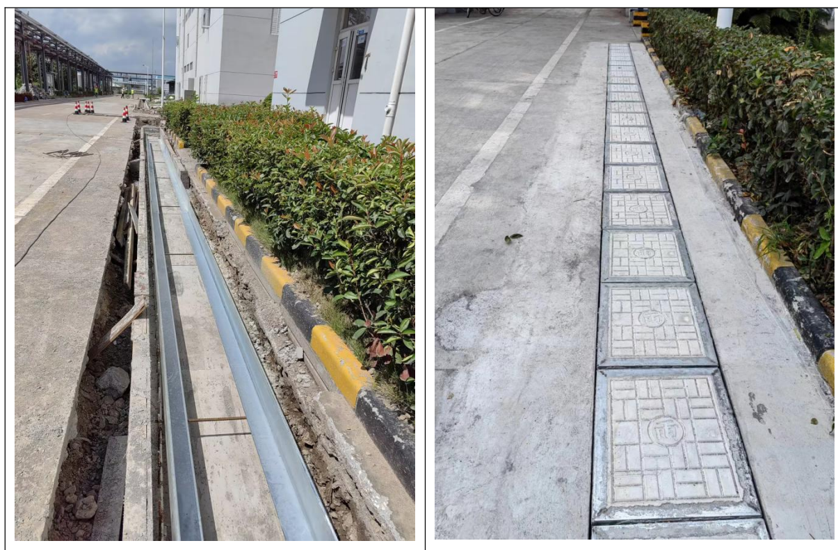
图 4.1-6 雨水管网提升改造现场照片
